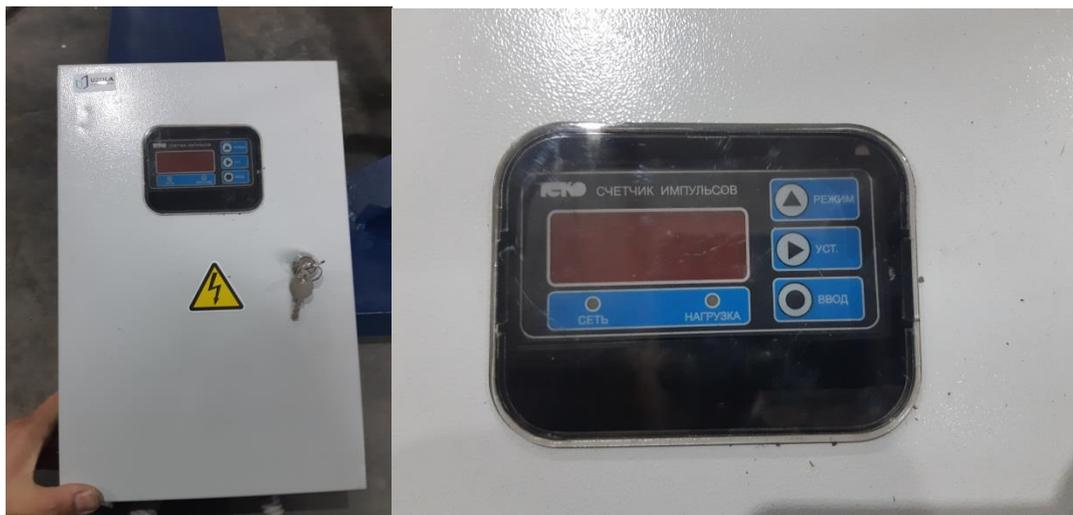
Рисунок А.4 – Пример общего вид электрощита с установленным в него счетчиком
